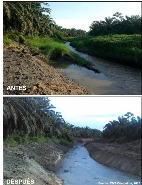
Figura 1. Labores de mantenimiento en canal de drenaje
